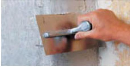
L'enduit de base "CASBAH" s'applique à la taloche de manière homogène
